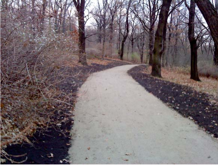
Einsatz von stabilisierenden Substraten auf Wegen im Hechtpark (Foto: Amt für Stadtgrün und Abfallwirtschaft, LH Dresden)
