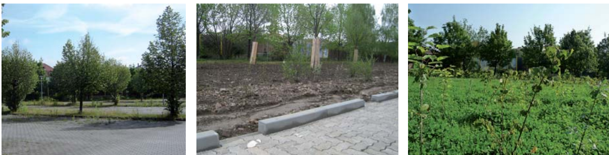
Vom Parkplatz zum Stadtwald, Leutewitzer Ring, Dresden (Ausgangssituation, Heisterpflanzung und Parkplatzentwässerung, Heister mit Krautschicht (Fotos: M. Hergert: 1,3; S. Rößler: 2)
