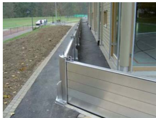
Mobiles Hochwasserschutz an Fenster-türen als nicht-strukturelle Maßnahme (Quelle: IBS Industriebarrieren und Brand-schutztechnik)
