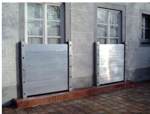
Mobiles Hochwasserschutz an Fenster-türen als nicht-strukturelle Maßnahme (Quelle: IBS Industriebarrieren und Brand-schutztechnik)
